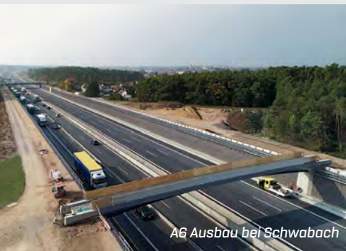
A3 Ausbau bei Würzburg
