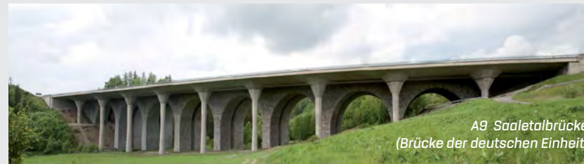
A73 Überführung einer Kreisstraße bei Lichtenfels
